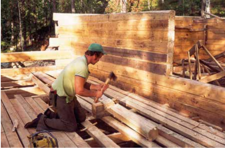
Valmetin hydraulikkaosastolla opastamani Veli Sormunen oli hakkaamassa mökkiäni, tämän myötä myös itse opin hirsirakentamisen taidot.
